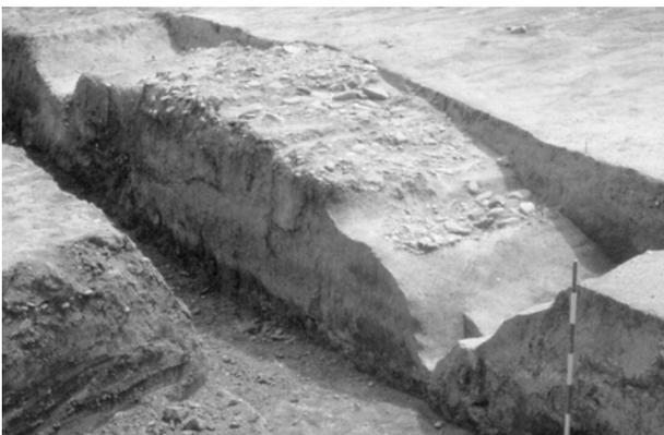
Fig. 17 – Sezione e scavo di una strada romana glareata corrispondente a un cardine della centuriazione bolognese. Il piano rotabile inghiainato dal profilo arcuato consentiva il deflusso delle acque meteoriche nei due fossi di scolo che fiancheggiavano la massciata.
