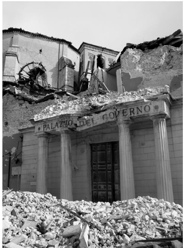
Fig. 2 - L'Aquila, edificio della Prefettura in crollo semitotale (foto P.G.)
